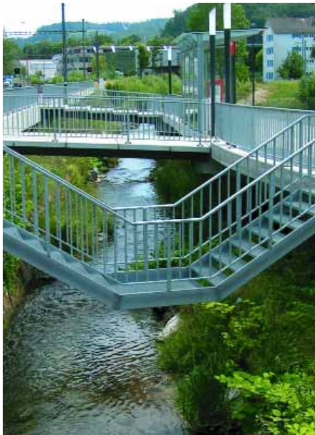
«Schtägeschtäg» oder «die etwas andere Brücke» des Ateliers Lang/Baumann, Burgdorf
